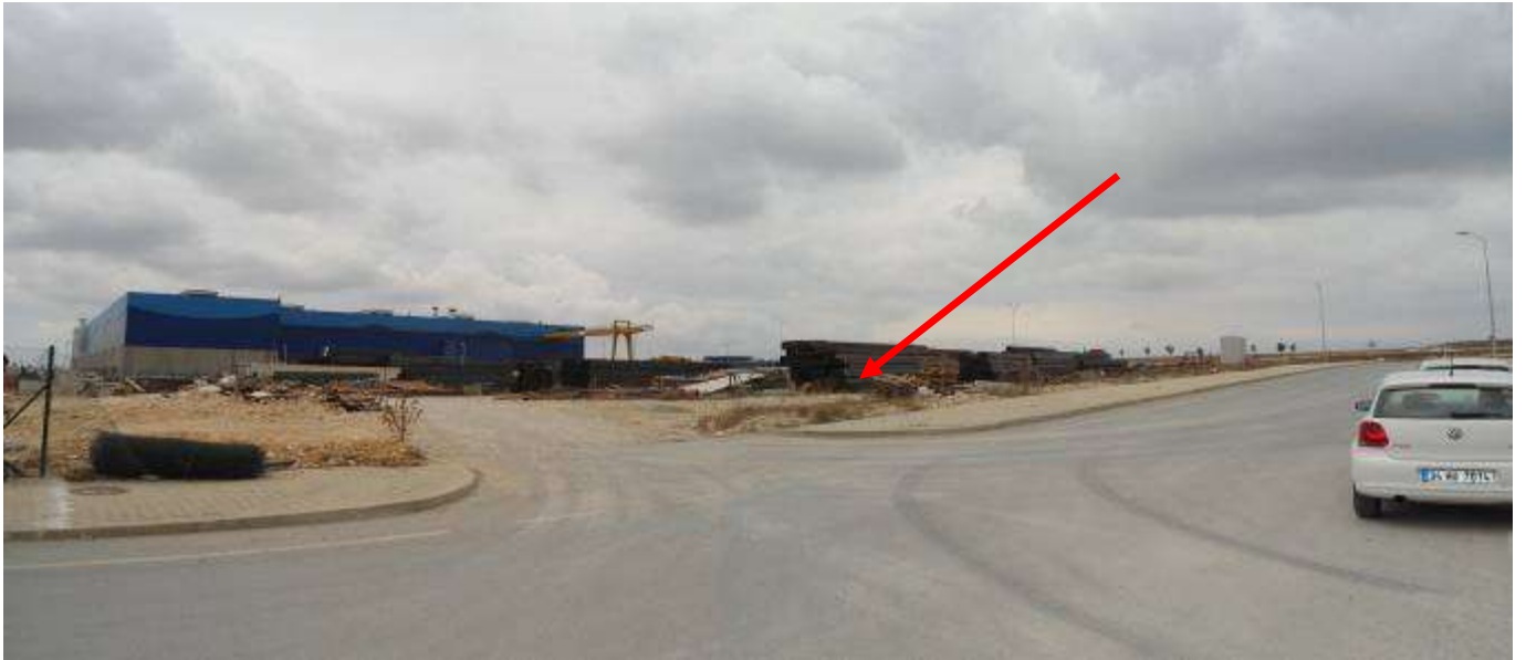
Parselin görünümü (17. Sokak'tan)
